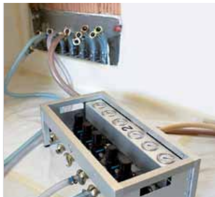
Rohrsanierung via Verteiler.
