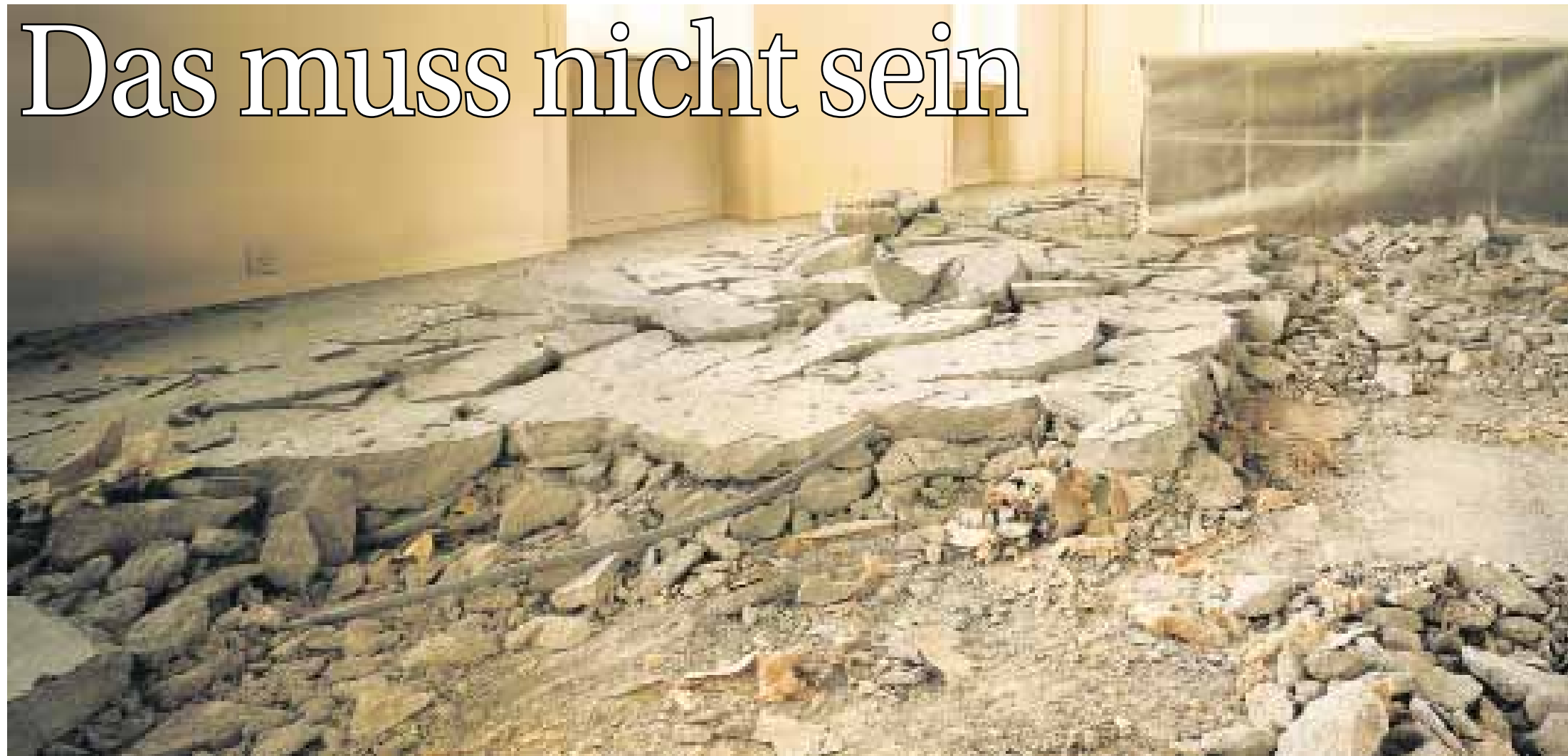
Bei Eigentümern nicht erwünscht: So kann es in der Wohnung aussehen, wenn die ganze Bodenheizung ersetzt werden muss.
