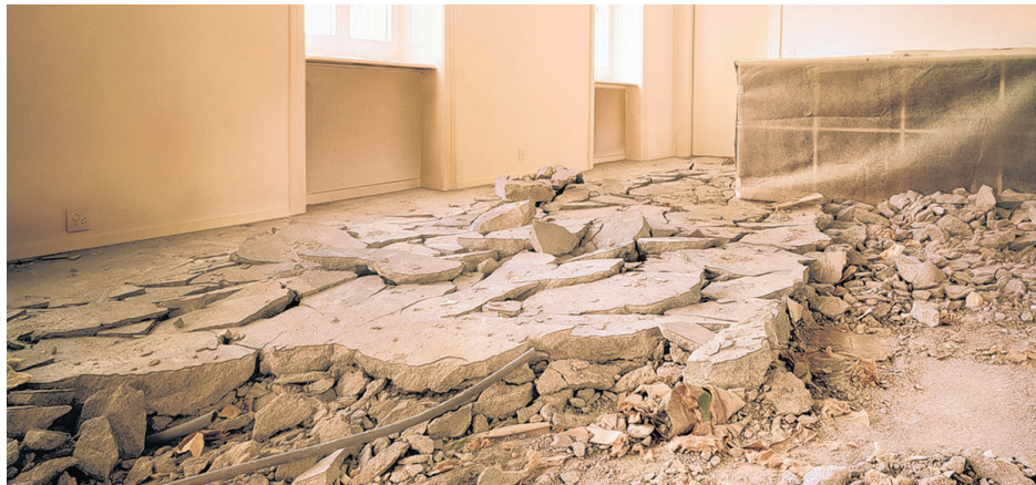
Mit dem HAT-System kann eine Totalsanierung der Bodenheizung vermieden werden.
