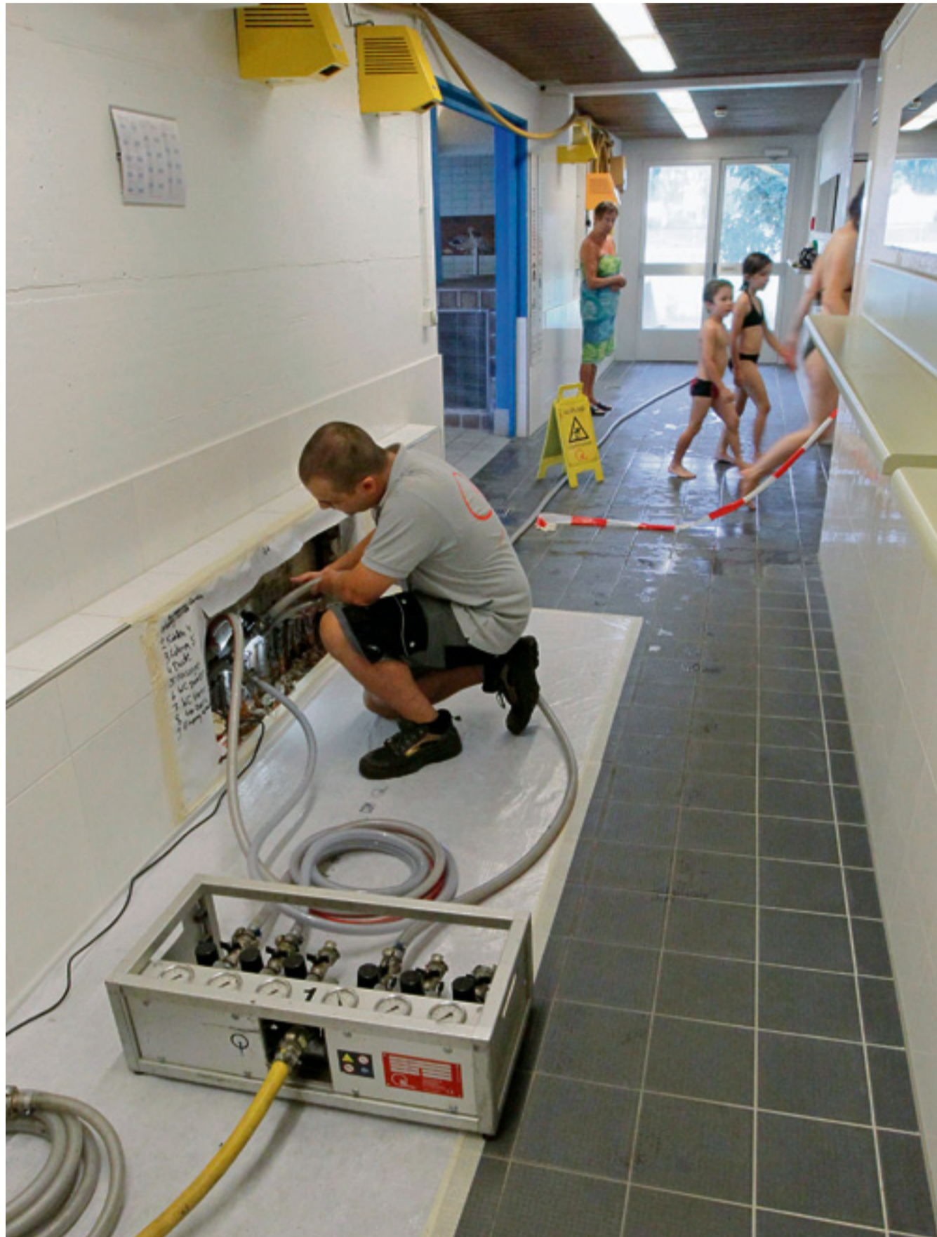
Während Stefan Stauffen die Rohre der Bodenheizung saniert, können die Gäste ungestört im Wasser planschen. Bild: Johanna Bossart
